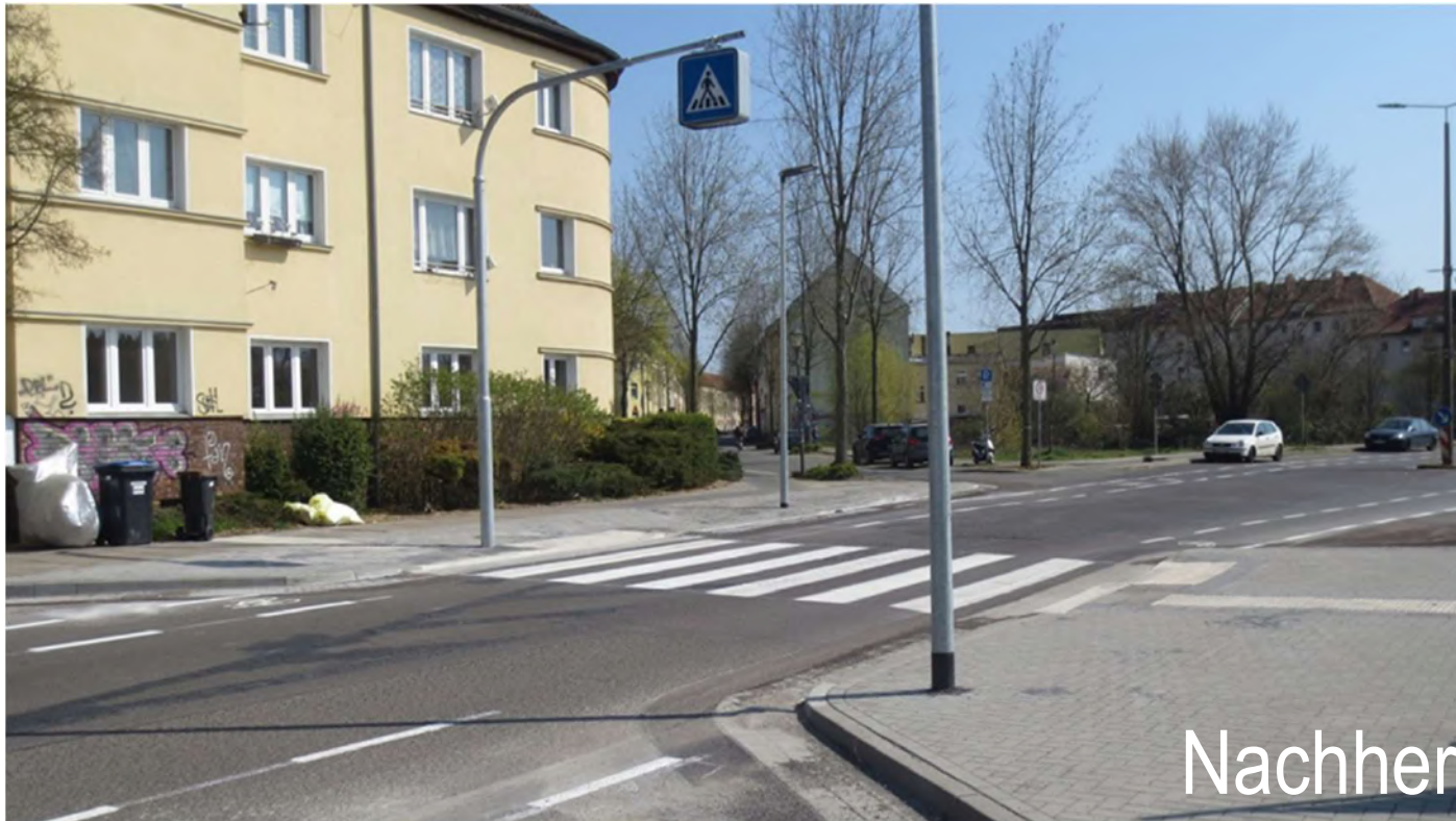
Brandenburg a.d.H. – Bauhofstraße: neuer Gehweg mit sicherer Querungsstelle
